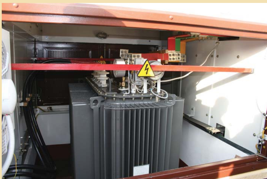
Отсек трансформатора
